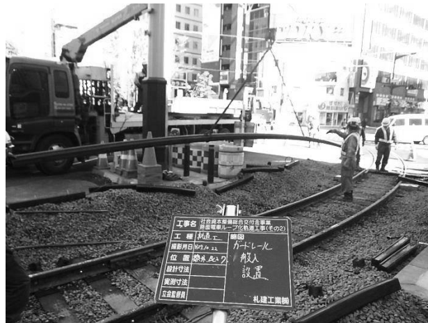
写真-2 ガードレール現場設置状況
