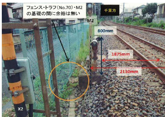
図4 踏切設備(起点側)現状写真 検知装置と線路の離隔
