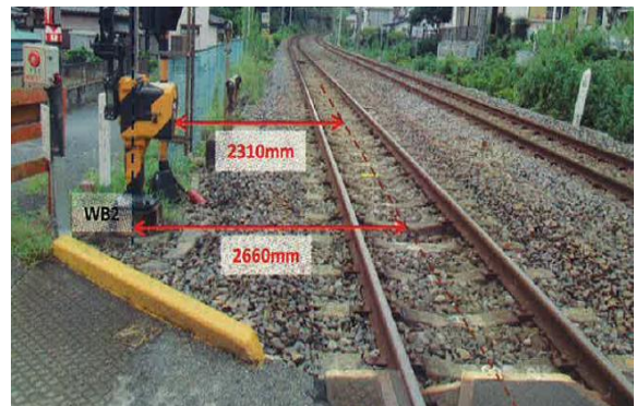
図3 踏切設備(起点方)現状写真 遮断棒と線路の離隔
