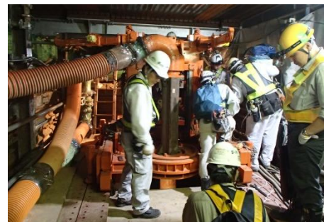
写真-1 ホーム下施工空間
