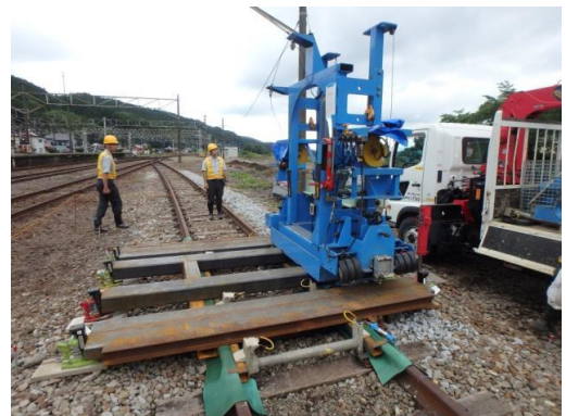
写真-3 実軌道における施工試験
