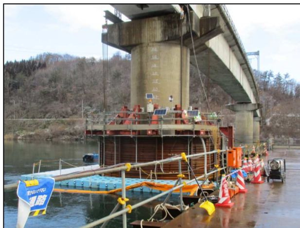
図.3 簡易仮締切工法
