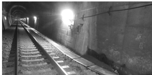
写真-2 トンネル内対策工完成
