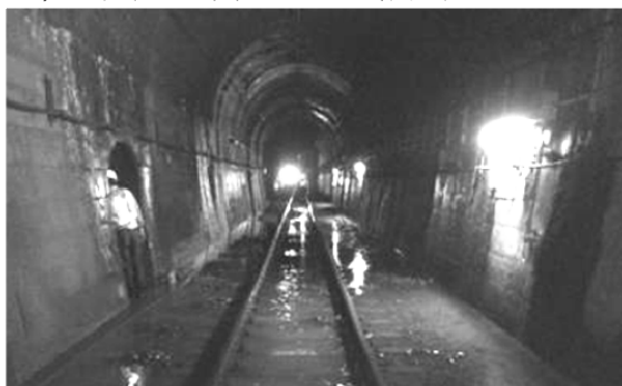
写真－1 現場状況
