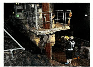
図7 クラッシュパイラー施工
