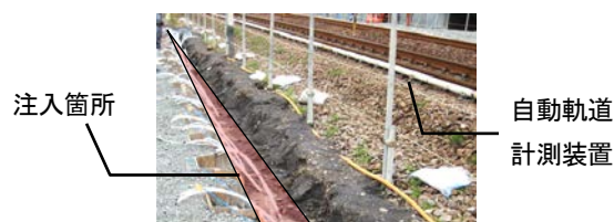
写真-1 DCI 多点注入工法による注入状況
