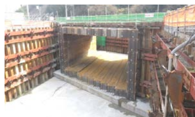
写真-2 函体施工完了時状況
