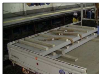
図-5 根太材を設置したPC板
