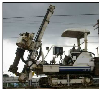
図-2 改良前杭打機
