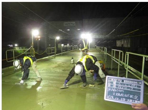
写真2 床版コンクリート打設状況
