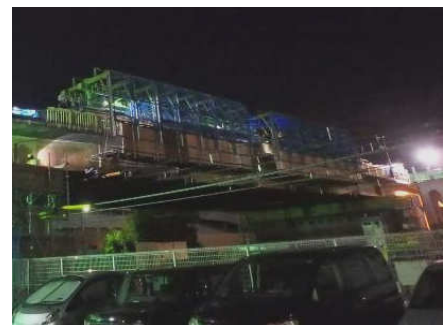
写真-2 移動式足場組立状況
