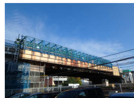
写真-4 移動式足場設置完了全景
