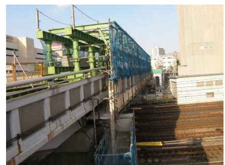
写真-3 移動式足場設置完了全景
