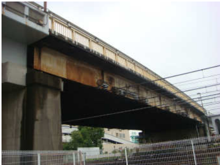
写真-1 対象こ線道路橋全景
