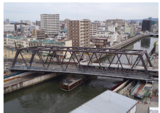
図-6 横取り後全景
