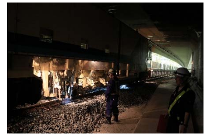
写真-1 軌道高上の様子
