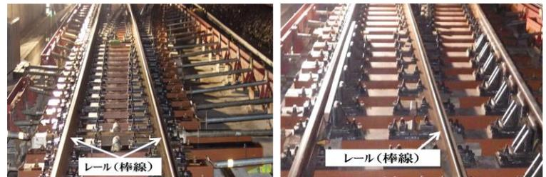
写真-2 分岐器用棒線化床板設置状況
