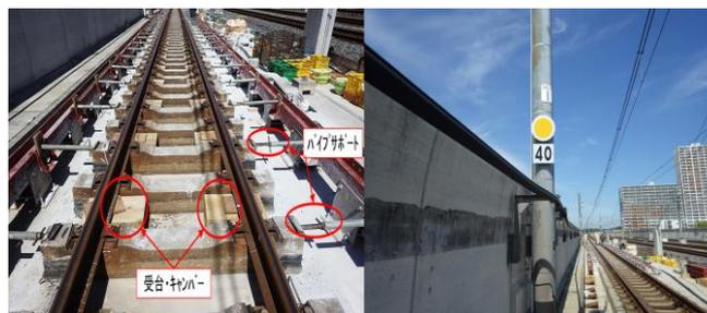
写真-1 仮受け状況・臨時信号機
