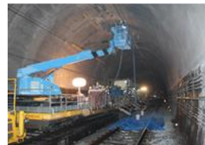
写真-3 施工状況写真
