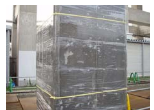
写真-5 ポリフィルムによる養生状況
