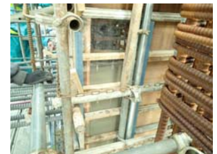
写真-3 透明型枠使用状況
