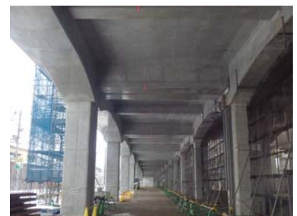
写真-6 打設完了状況
