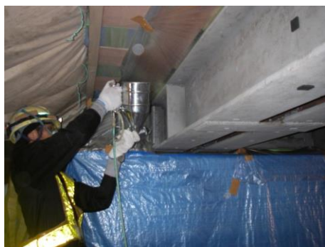
写真-1 ゴムラテックスモルタルの吹付状況
