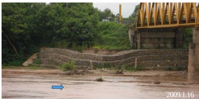
図1 ボリビア、橋梁の護岸工
