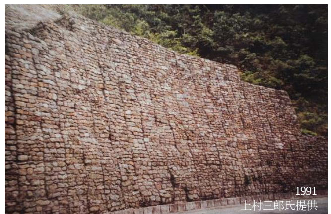
図6 ネパール、道路法面擁壁
