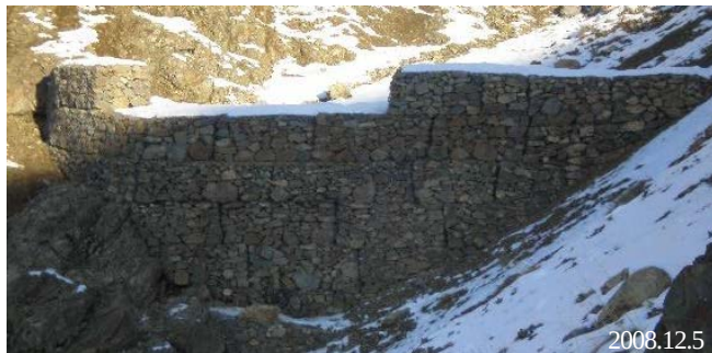
図4 イラン、テヘラン市防災のために建設された砂防ダム
