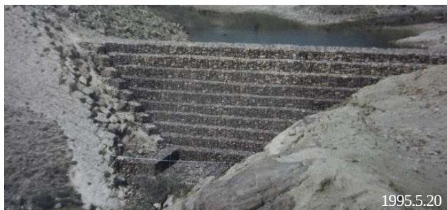
図5 パキスタン、貯水ダム
