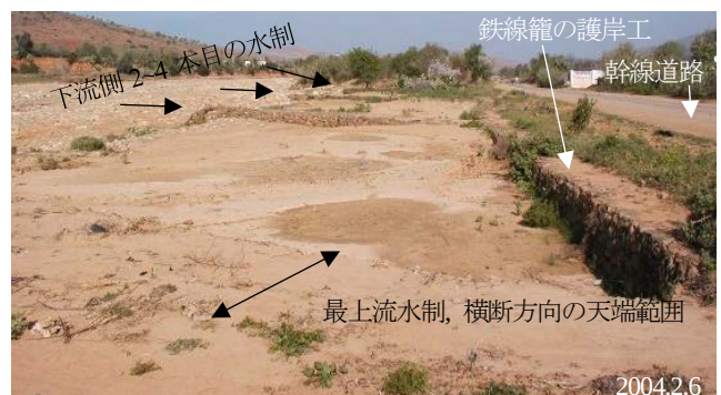
図3 モロッコ、道路侵食対策のために設置された水制
