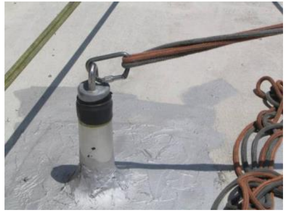
写真-2 安全帯取り付け金具 5)
