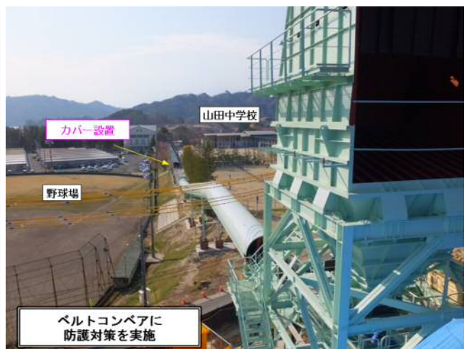
写真-1 県立病院用地からのベルトコンベアによる土砂搬出
