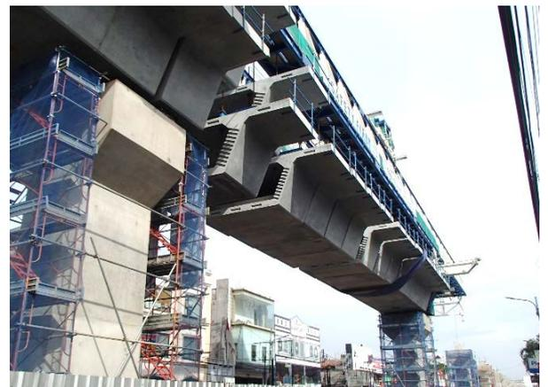
写真2 セグメント吊上げ完了・接合状況
