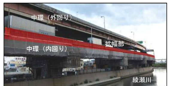
写真-1 拡幅現場状況
