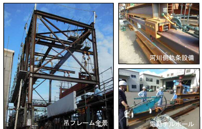
写真-2 架設試験状況
