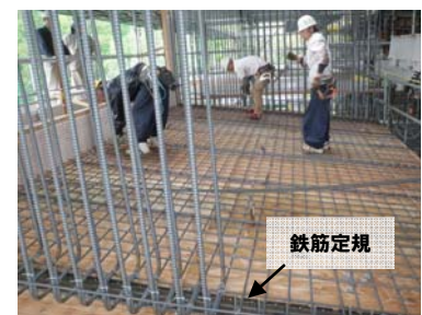
写真-4 鉄筋組立状況
