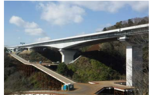
写真-1 雄ノ山高架橋
