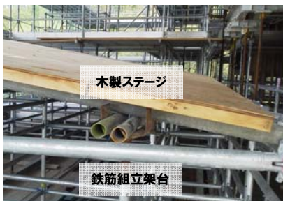
写真-2 鉄筋組立架台
