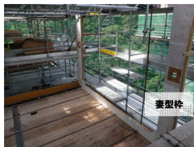
写真-3 妻型枠組立
