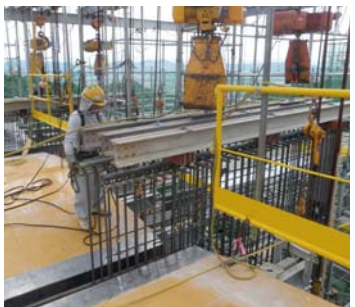
写真－８ 鉄筋引込み状況
