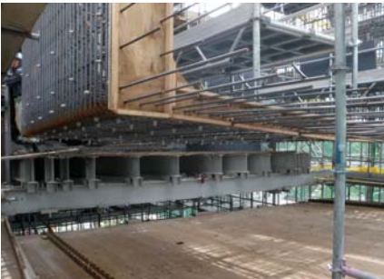
写真－７ 先組鉄筋吊上げ状況
