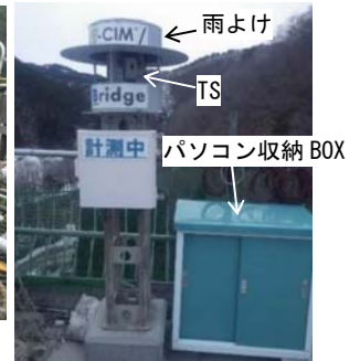
写真-6 柱頭部にセットした TS
