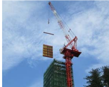
写真-3 大型システム型枠設置状況
