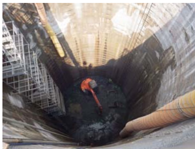
写真-1 掘削状況
