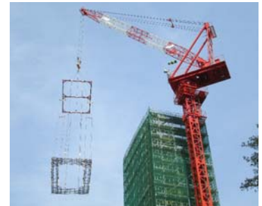
写真-4 鉄筋架設状況 (NOP キャリイ工法)
