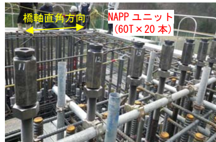
写真-5 PC 鋼棒配置状況 (柱頭部 1 リフト施工時)
