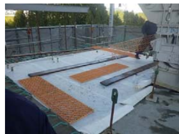
写真-1 養生マート②の敷設状況
