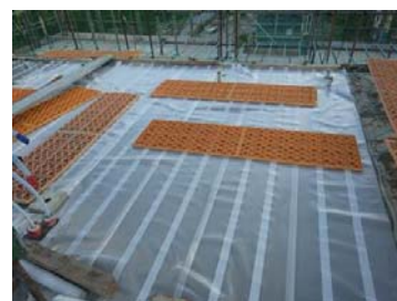
写真-2 養生マート③の敷設状況
