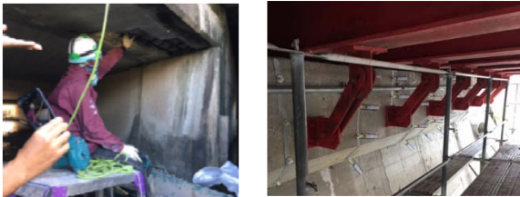
写真-1 狭隘な作業空間における橋梁補修工事
