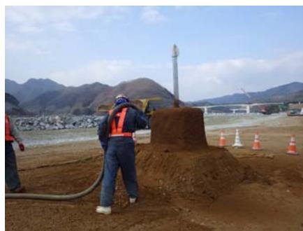
写真—5 層別沈下計ロッド吹付け
