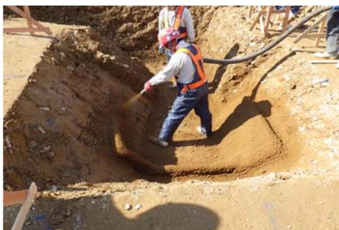
写真—4 土圧計設置盤吹付け
