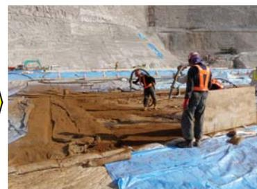
写真—2 着岩材の施工方法
