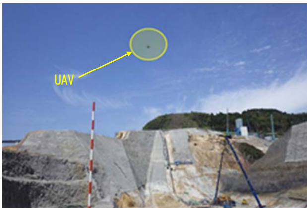
写真—2 UAVによる写真測量状況
