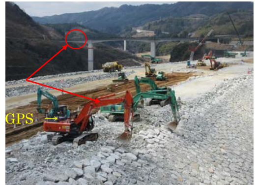
写真—1 MGによるリップラップの施工
