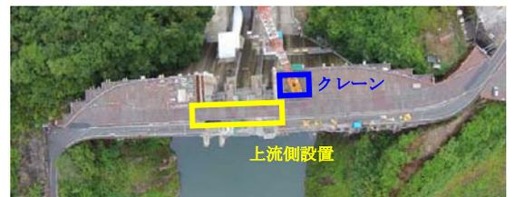
写真-4 仮設橋梁の設置状況（上流）
