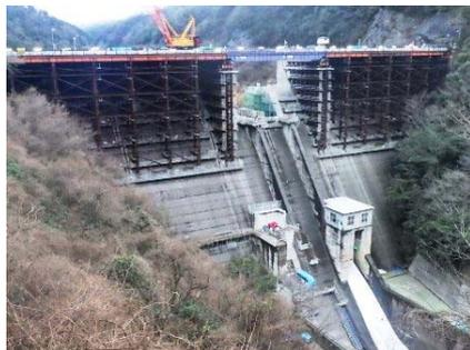
写真-1 浜田ダムと仮設構台
