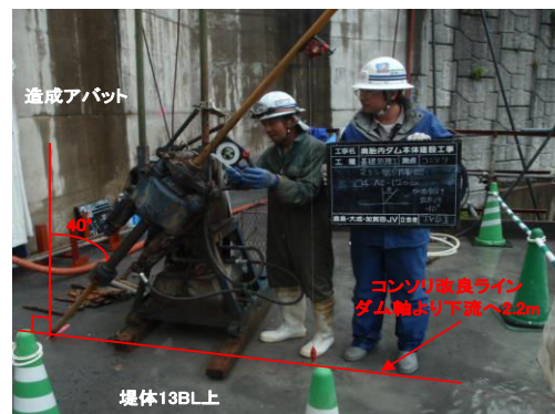
写真-1 コンソリ(斜孔)施工状況(堤体上にて)
