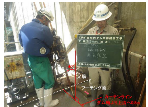
写真-2 カーテン施工状況 (右岸上流フーチング上にて)
