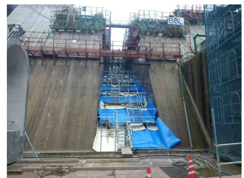
写真-1 保温養生状況
