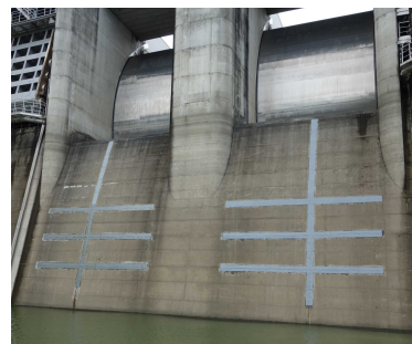
写真-2 実ダム（上流面）での試験施工状況（B ダム）
