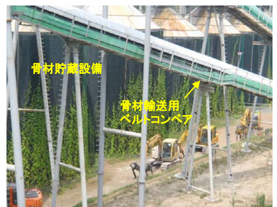
(ii) 骨材貯蔵設備への寒冷紗・ツタ系植物の設置 骨材輸送用ベルトコンベアへのカバー設置
