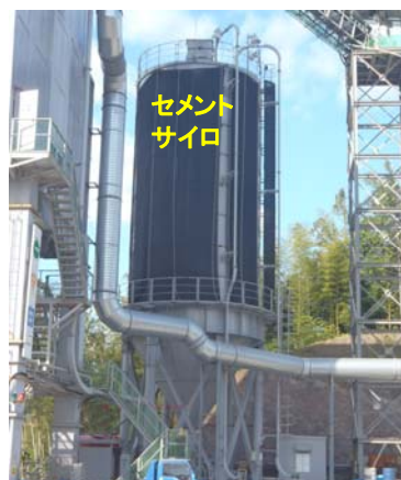
(i) セメントサイロへの寒冷紗の設置
