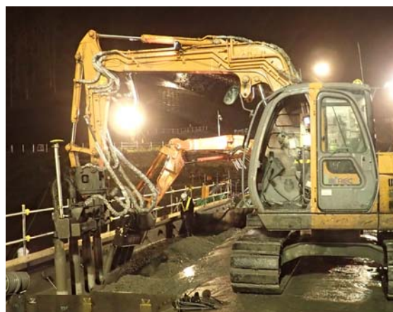
写真-1 施工状況
