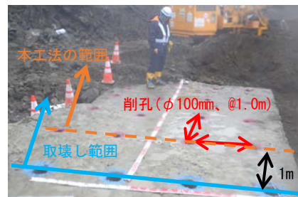
写真-1 削孔完了状況
