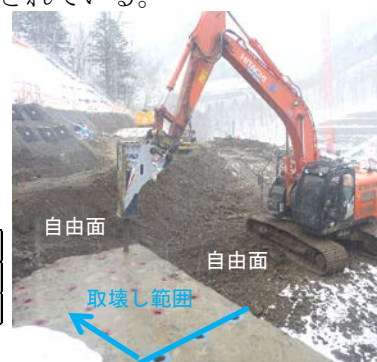
写真-2 取壊し状況
