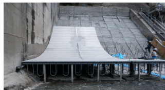
写真-5 ステンレス板の設置状況
