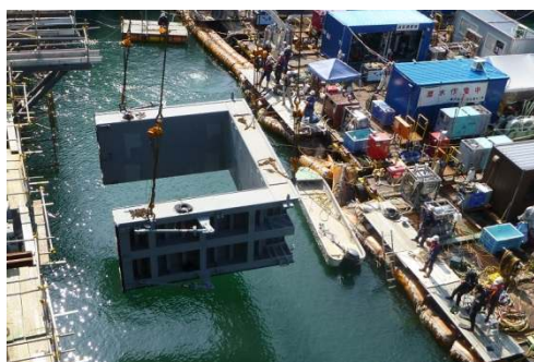
写真-2 仮締切りの設置状況
