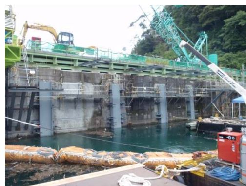
写真-1 仮締切り側部戸当りの設置状況
