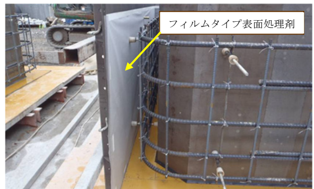
写真－4 鋼製型枠とフィルムタイプ表面処理剤
