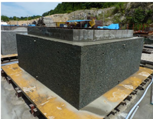
写真－6 粗面仕上げ
