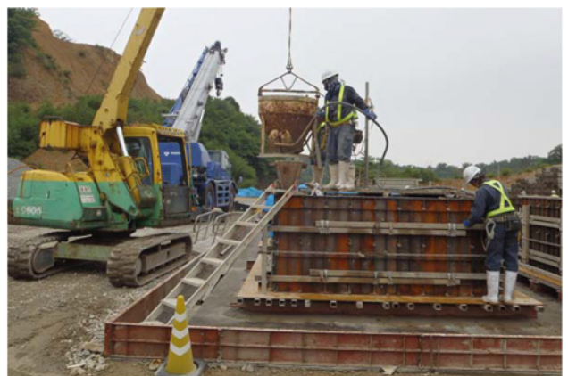
写真－5 コンクリートの打設状況
