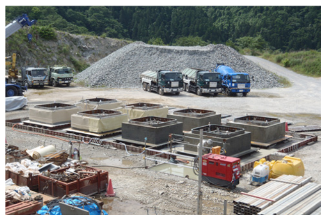
写真－2 製作ヤード
