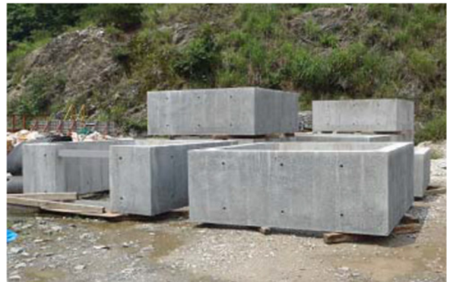
写真－1 エレベータシャフトプレキャスト型枠
