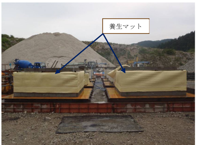
写真－7 養生（外枠脱型後）
