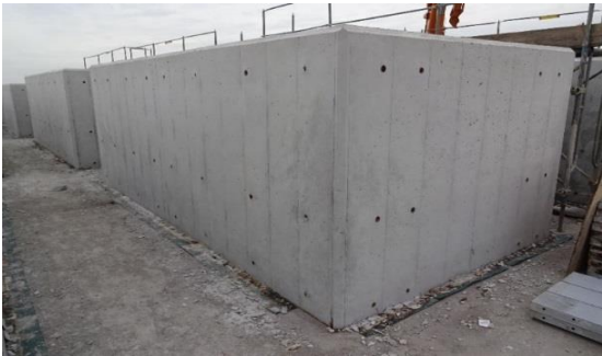
写真-2 コンクリート表面性状
