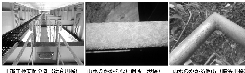
写真-1 検査路の外観
