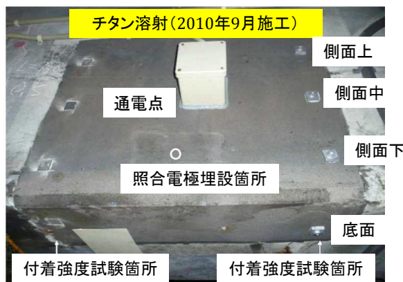
写真-1 試験施工箇所の概要
