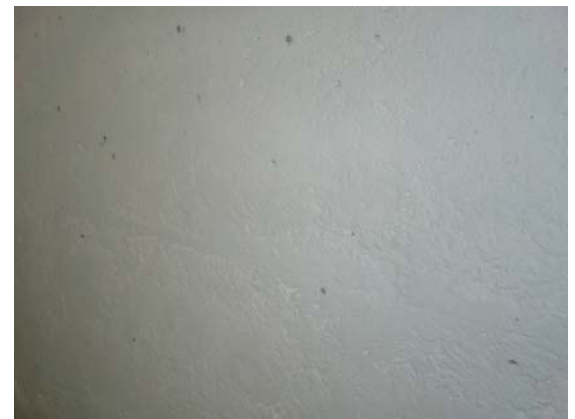
図-5 2次封孔処理後の溶射皮膜の状況
