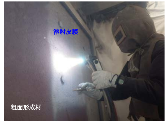
図-4 プラズマアーク溶射の状況
