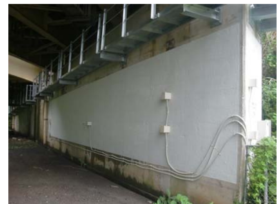
図-6 配線・配管作業後の施工面の状況
