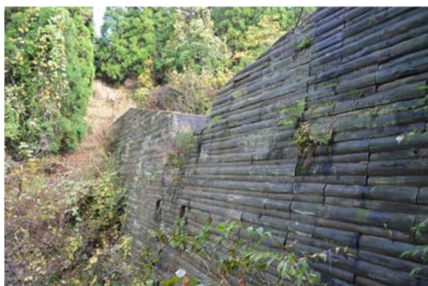
写真 1 堰堤の下流側 (No.1)
