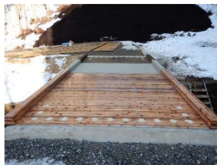
写真-7 舗装前の状況
