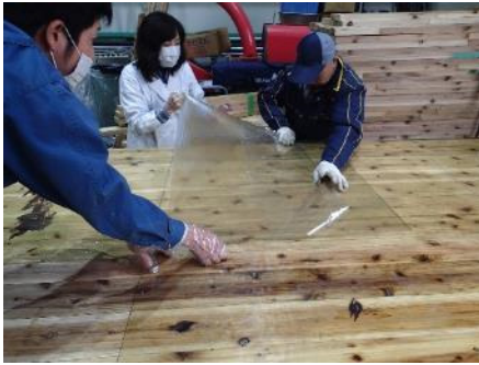
①FRP によるラッピング
