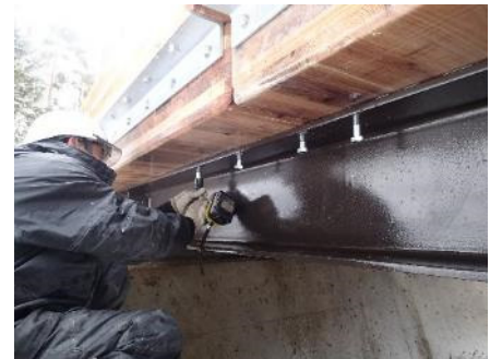
写真-5 CLT床版の固定
