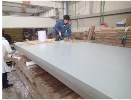
②ポリマーセメントによる被覆 写真-2 CLT の防水加工
