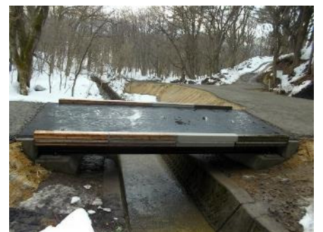
写真-8 舗装した実験橋
