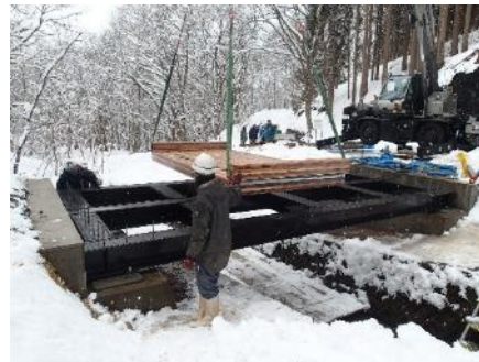
写真-4 CLT床版の架設
