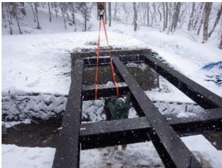
写真-3 主桁・横桁の架設
