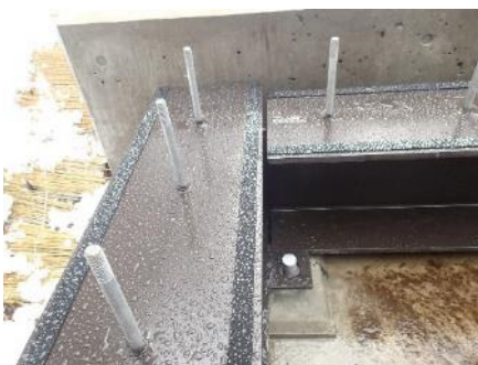
写真-6 主桁・横桁の架設
