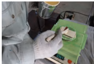
写真-3 環境遮断剤施工状況
