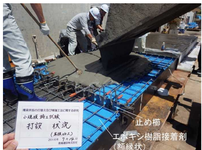
図-2 UFC打込み状況
