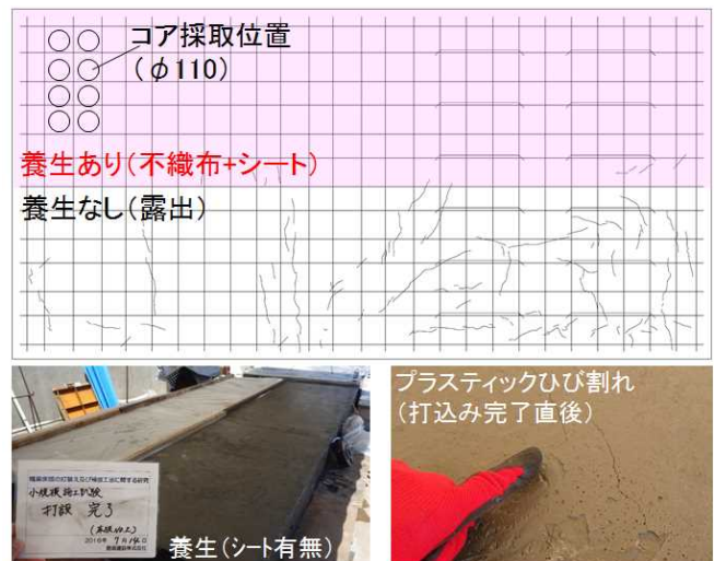
図-3 UFC 上面のひび割れ発生状況
