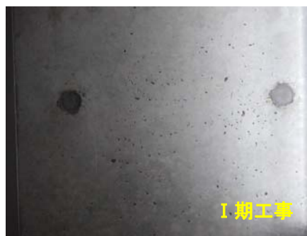
写真-3 構築後のコンクリート表面
