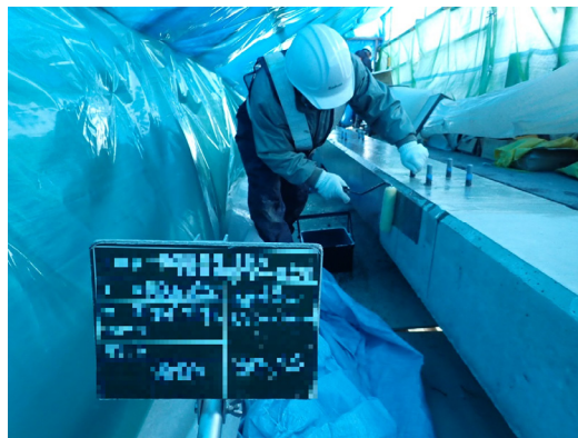
写真-1 厳冬期における防寒仮囲い内でのシラン塗布状況の一例（手前の黒板は画像処理を行っている）
