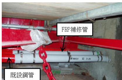
図 1 FRP 補修管の補修例
