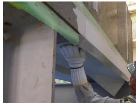
写真-2 水切り部施工状況
